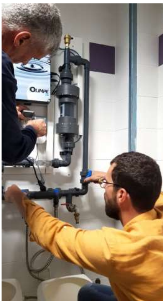
Installation de l'équipement Olimpe Pro au restaurant scolaire de l'Houmeau
