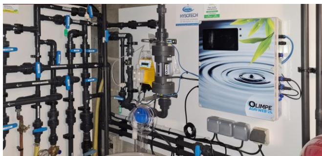
Installation avec 1 cellule jusqu'à 40 m 3 d'eau traitée/jour
